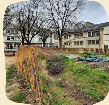
Construction de noues
